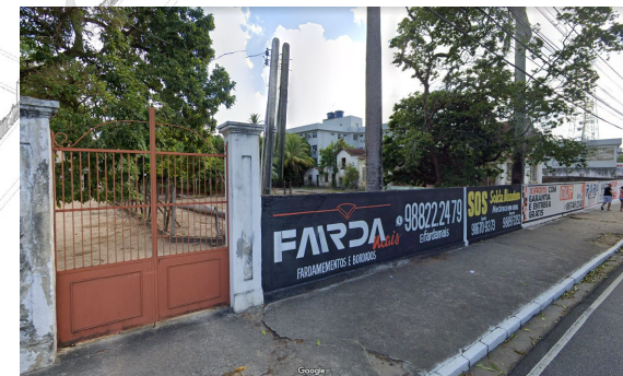
1 MURO DIVISA FRONTAL
